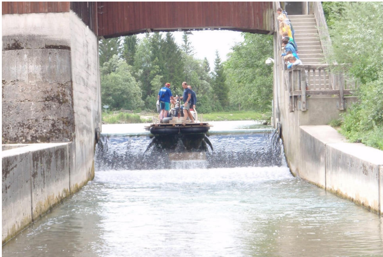
Stauwehr bei Icking mit Floßbrutsche © Prummer
